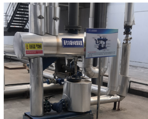
蒸汽冷凝水回收系统
